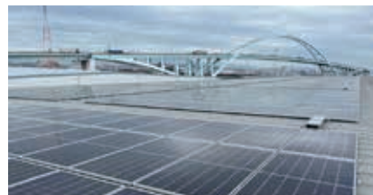
IIF 大阪住之江ロジスティクスセンター
